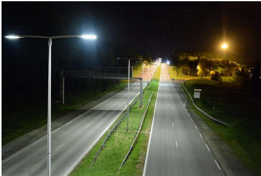
Situation réelle LUMIROUTE (Source : rgra)
